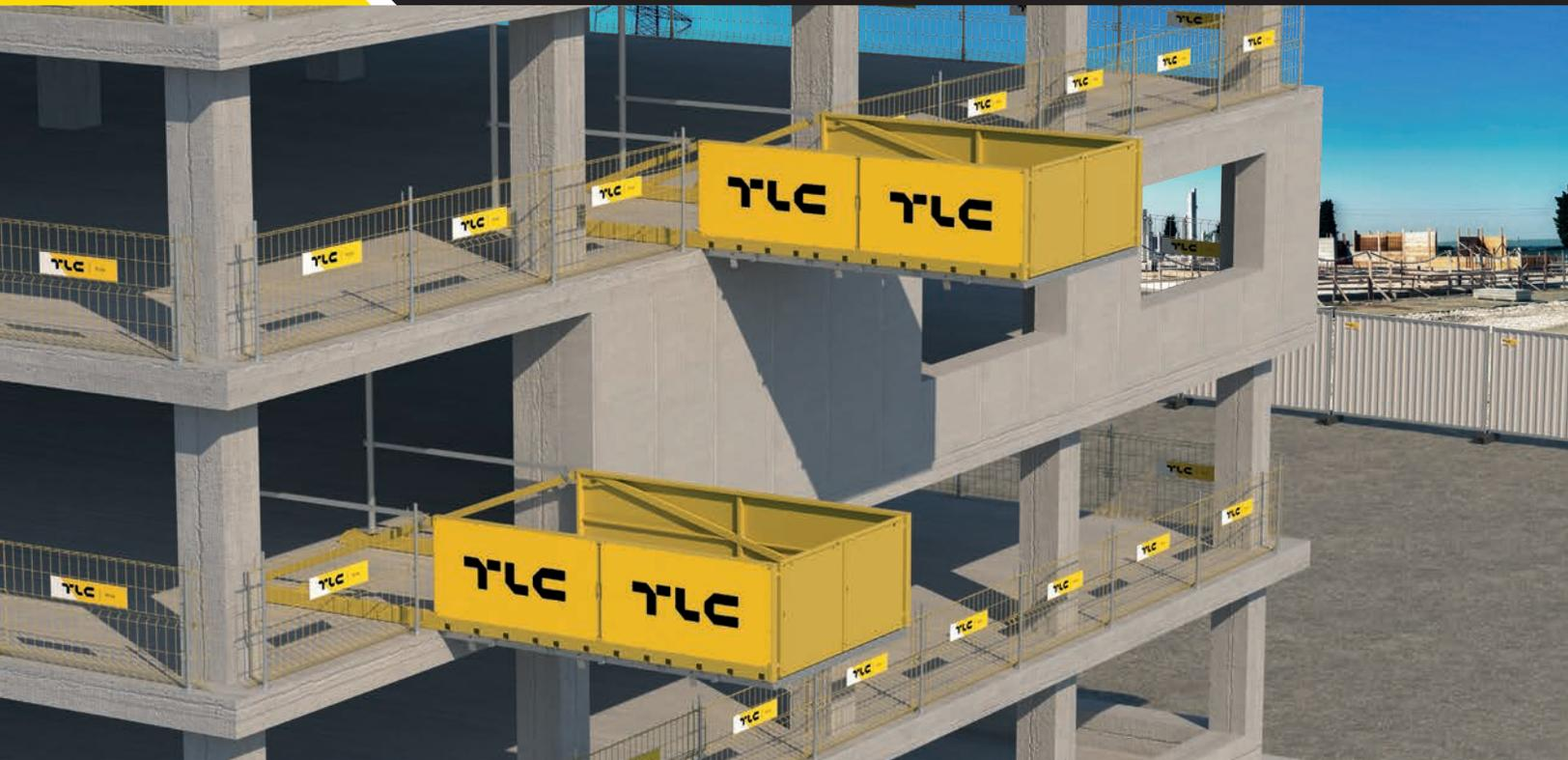
Die TUP Verladebühne - erhöht die Sicherheit beim Verladen der Materialien vom Baukran im Hochbau. Kann an verschiedenen Etagen des Gebäudes angebracht werden. Die Bühne wird als Bausatz in Einzelementen geliefert, was einen schnellen und **einfachen Transport, sowie ihre Montage und Demontage gewährleistet.**
